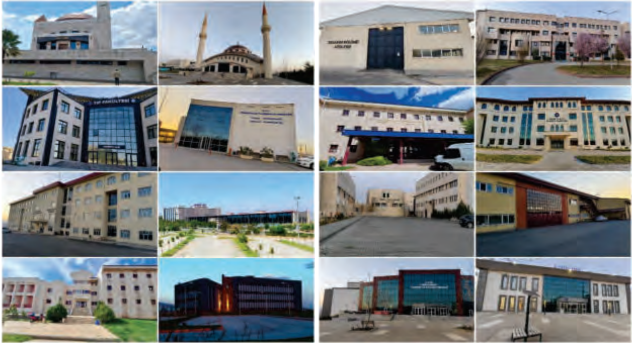
Şekil 3: Bina Dış Yalıtım Görünümleri
